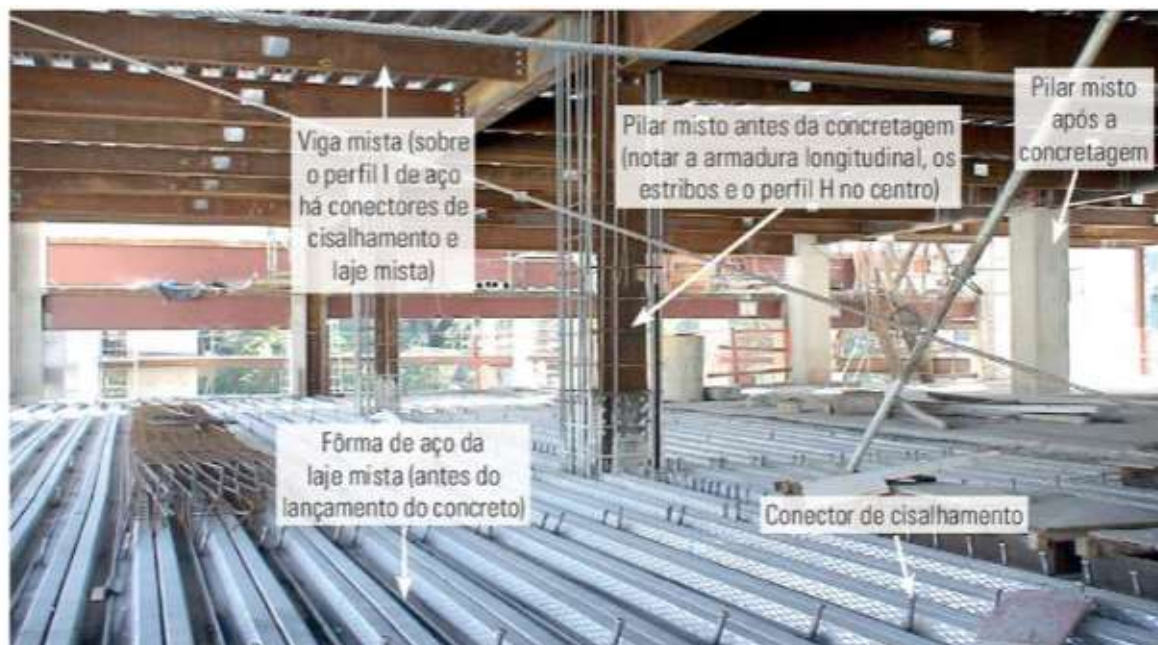
FIGURA 1.2 Exemplo de obra com elementos estruturais mistos de aço e concreto.
